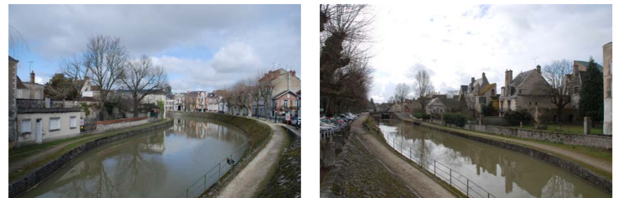
Fig. 15 : Canal de Briare et le Loing à Montargis
